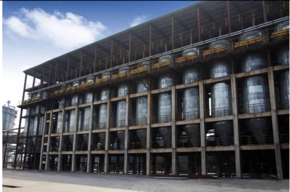
高炉煤气布袋除尘系统
