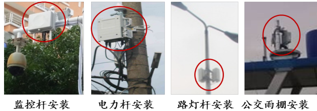
图 3.1- 1 微基站杆塔安装
