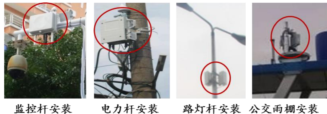
图 3.1- 1 微基站杆塔安装
